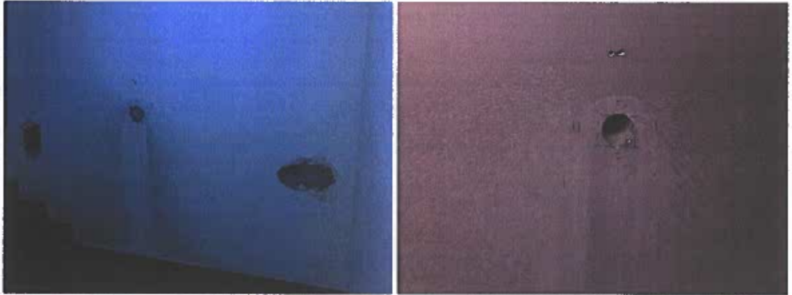
Şekil 2.12: Yapıdan alınan karot numuneleri ve donatı sıyırma işlemleri sonrası karot boşluklarının doldurulmuş ve sıyrılan beton örtüsünün kapatılmış örnekleri.
